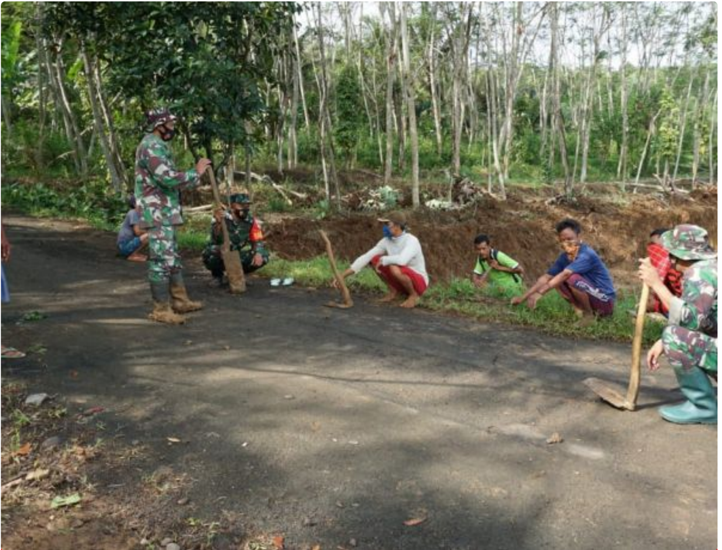
Warga berpartisipasi dalam pembuatan jalan di program TMMD
